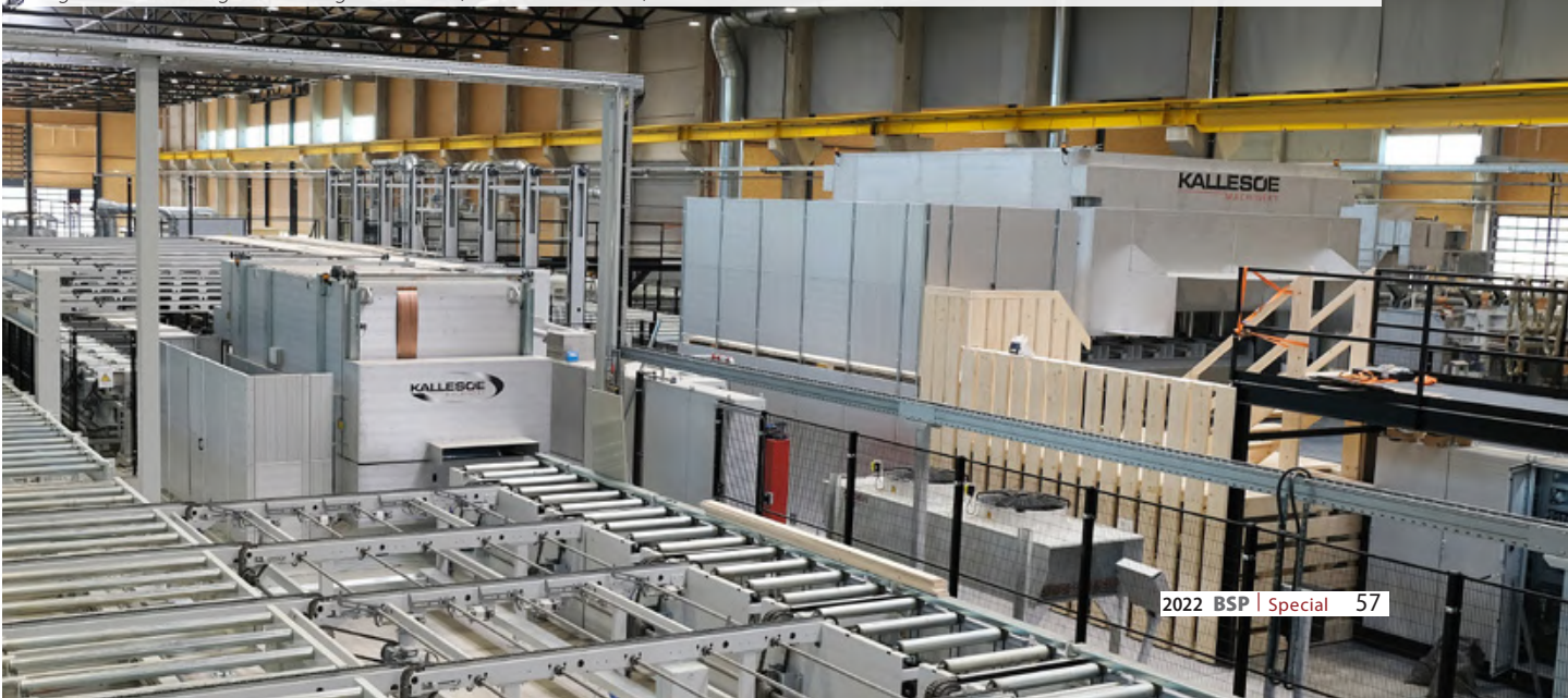
Kallesoe realisierte bei LOC Holz drei Hochfrequenzpressen: Die Presse rechts mit 400 kW ist die leistungstärkste, welche die Dänen jemals gebaut haben. Die Presse links übernimmt die Flankenverklebung von jeweils drei Längslagenlamellen. Die dritte Presse übernimmt die tragende Verklebung der Querlagenlamellen (siehe nächste Seite)
